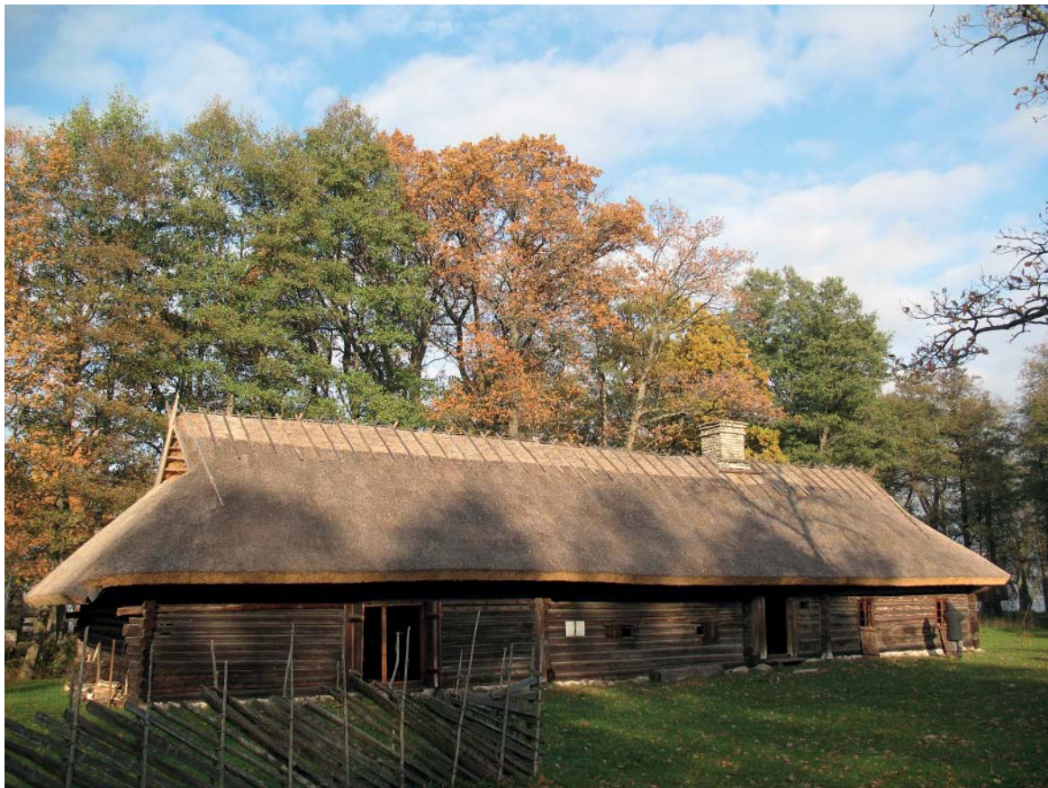
Hiiumaa Kolga taluhoonelamu
